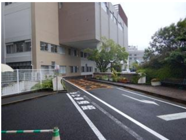
②建物手前を通り奥に進む
