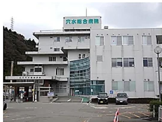
検査機能維持が厳しい穴水総合病院
